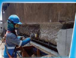
งานซ่อมแซมบำรุงรักษาโครงสร้าง
