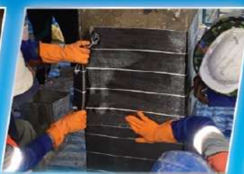
งานเสริมกำลังโครงสร้าง
